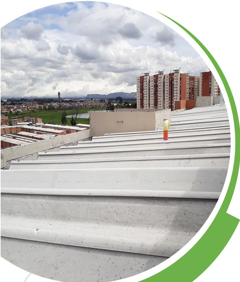
Las cubiertas de las torres 3 y 4 están compuestas por Canaletas en fibrocemento que van en varios sentidos y desaguan a una placa-canal que luego conducen las aguas lluvias a las bajantes protegidas por ductos que van a descargar a las cajas de inspección. Para las torres 1 y 2 las cubiertas están diseñadas en placa maciza transitable en concreto con bajantes para las aguas lluvias.
