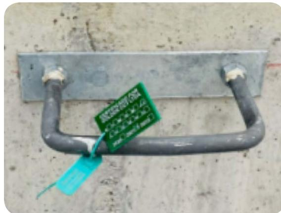
Estos anclajes están compuestos por unos ganchos en "U" de  $\frac{3}{4}$ " en acero galvanizado, instalados y certificados por la empresa Golden Cut Ltda. Estos anclajes se encuentran probados y certificados para una carga de uso máxima de 3.600 libras/fuerza (15.83 kilonewtons, 1607 kg/f)
