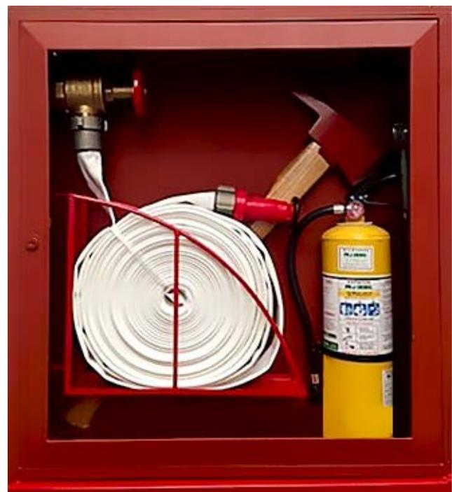
Gabinets contra incendio clase II de tamaño 0,77 ancho, 0,77 altura y 0,22 de profundidad, contruidos en lámina de acero calibre 20 para el cuerpo y calibre 18 para las puertas, entregados con dos capas de pintura anticorrosivo y vidrio templado de 4 mm.
